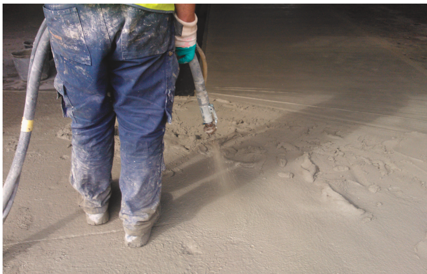
Betonreparatie met SP45 Sputmortel R3 (SPCC)
